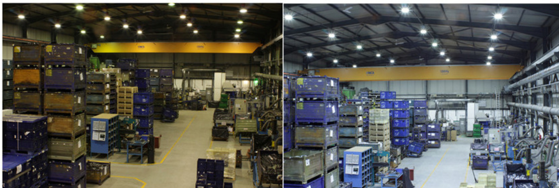
vorher: 400W Hochdrucknatriumdampflampen
