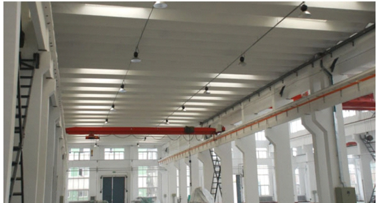
Bild: Modell LCLBKN428 200W Hallenstrahler
